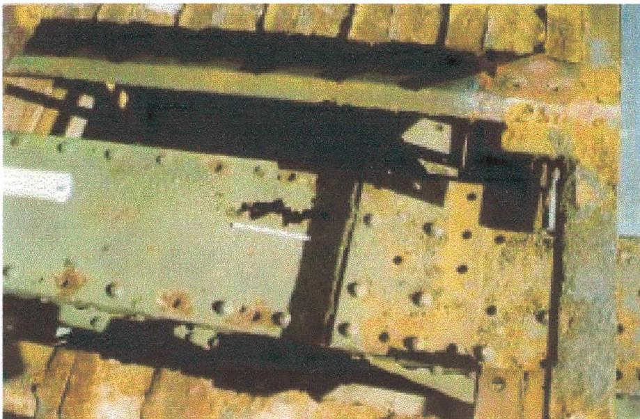
Figura 2 – Detalhe do estado da corrosão da corda superior da treliça vão 24 lado sul da ponte Hercílio Luz
