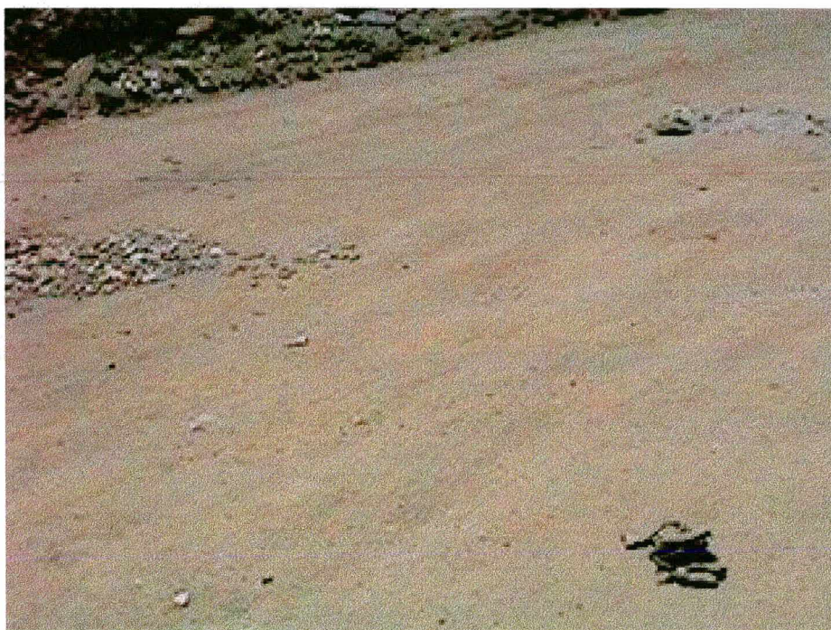
Figura 2.5 - Vista parcial da Rua Dr. João de Oliveira. Nota-se a ausência de calçamento neste trecho da rua.
