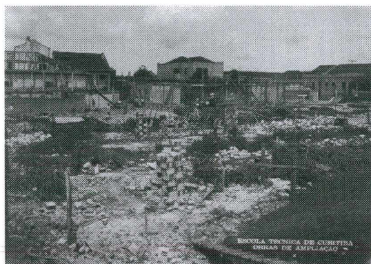
Figura 34 - “Obras de ampliação da Escola Técnica de Curitiba – 1946”
