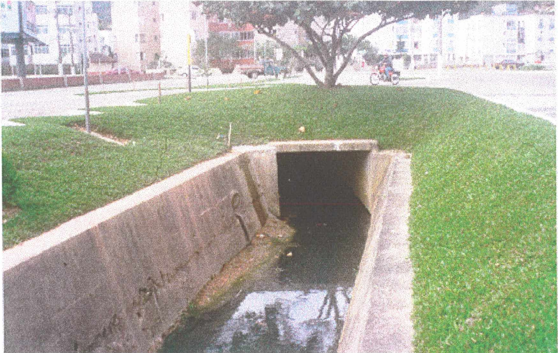
FIGURA 5 Galeria de drenagem oculta sob as ruas
