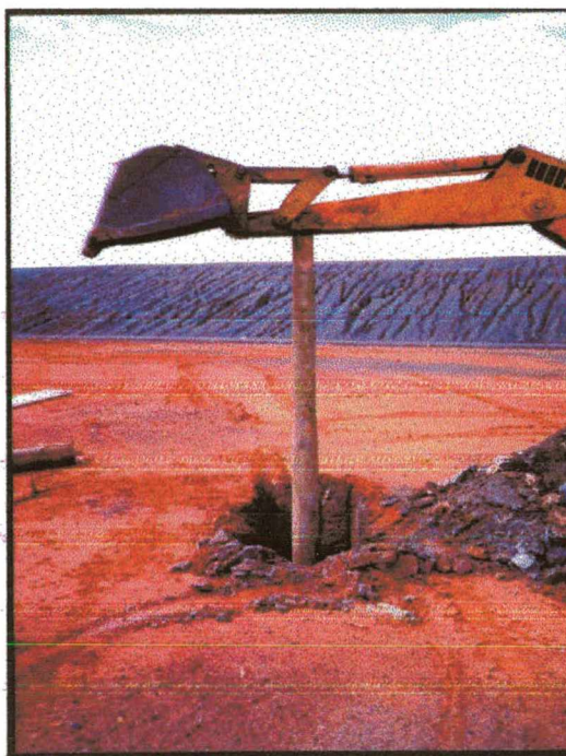
Fig. 10: Instalação de poço de coleta no aterro.
