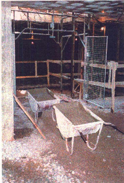
Foto 5.4 - Filas de jericas com concreto a espera de transporte
