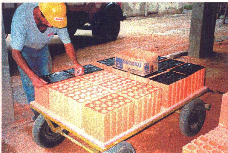
Foto 5.3- Vedação dos tijolos cerâmicos para utilização na confecção da laje nervurada
