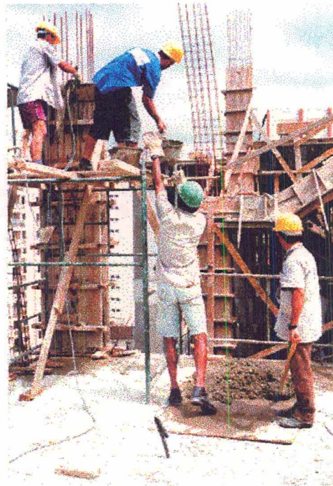
Foto 5.5 - Equipes numerosas devido ao meio arcaico de transporte de materiais
