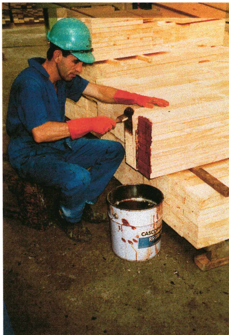
FOTO 3. 4 Aplicação do adesivo com pincel
