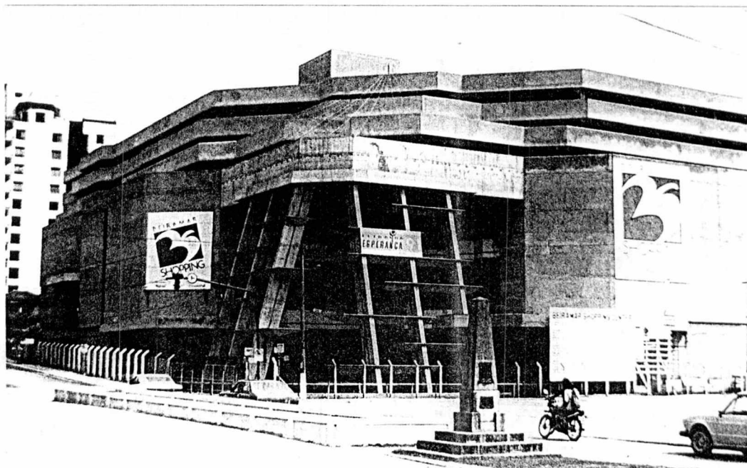
FOTO 15 - Shopping Center em construção.
