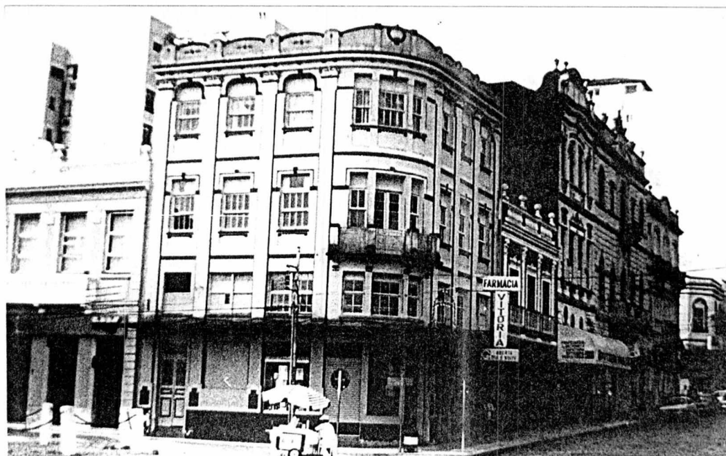
FOTO 8 - Conjunto de edificios tombados na área central.
