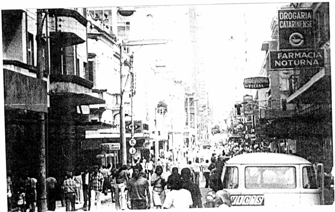
FOTO 4 - Rua Felipe Schmidt, antes da construção do Calçadão.
