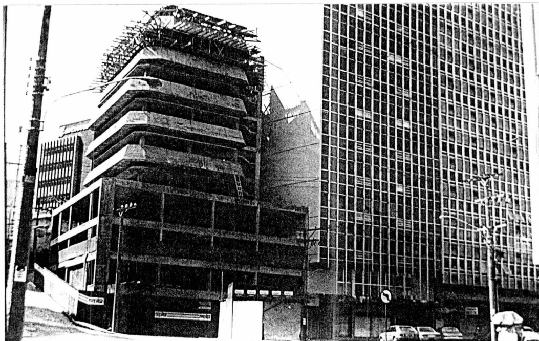
FOTO 9 - Edifício em construção na área central, sob a lei número 3338/89.
