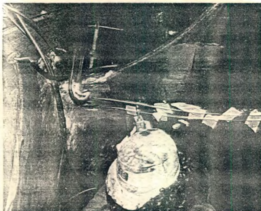
Fig. 4.10 - Detalhes da instalação dos extensômetros.
