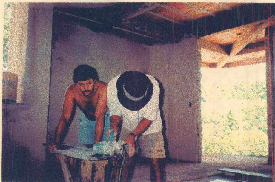
Foto 5.1. Corte de peças de Granito no canteiro
