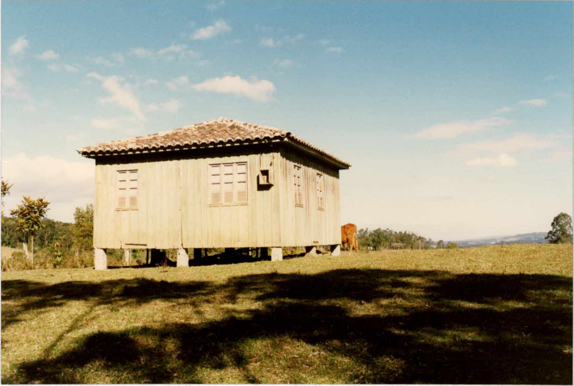
Figura 9 - Sede de propriedade sub-utilizada
