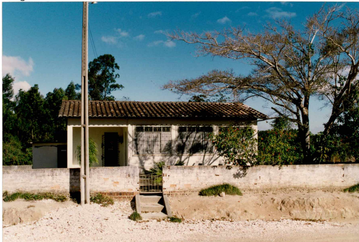
Figura 6 - Escola de ensino fundamental. Zona Rural.
