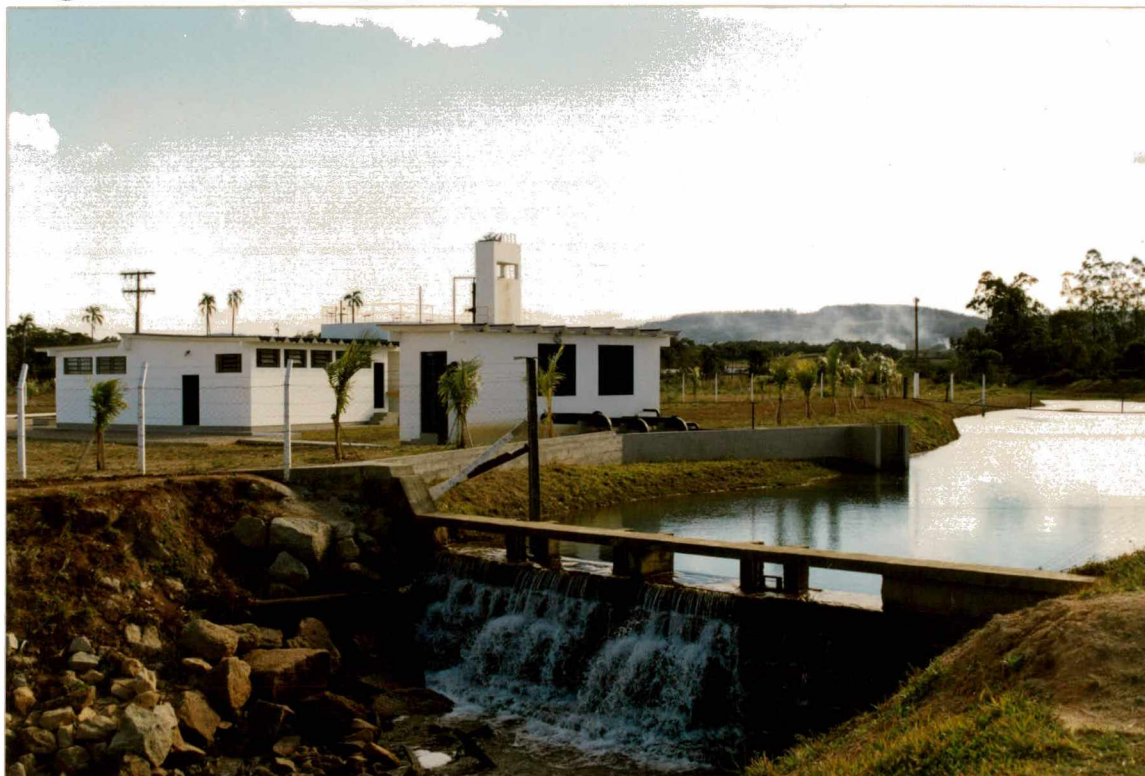
Figura 5 - Estação de captação de água
