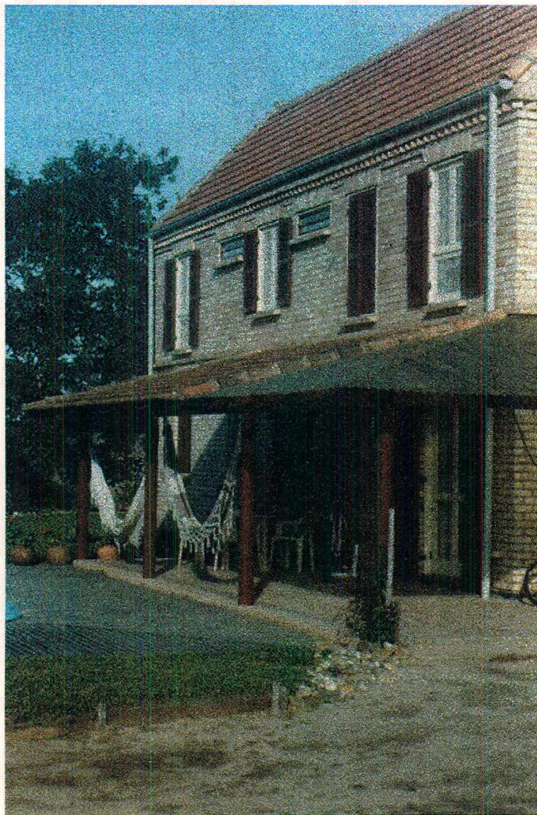
Figura 3.10. Foto da fachada nordeste da casa nº2
