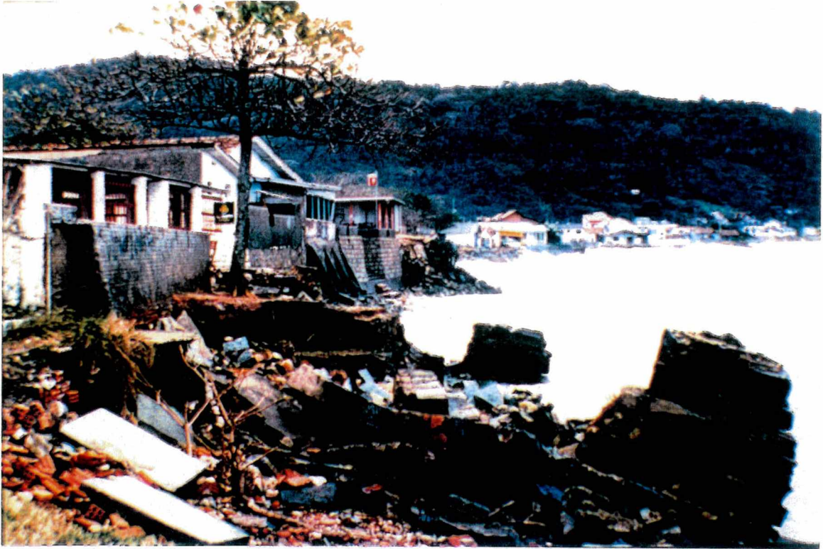
Foto 21. Desaparecimento da praia e destruição de construções no setor Sul durante um forte episódio erosivo (10/90).
