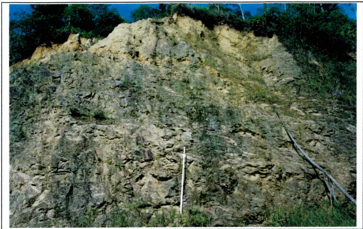
Figura 4.1 - Jazida de material para o trecho: POMERODE
