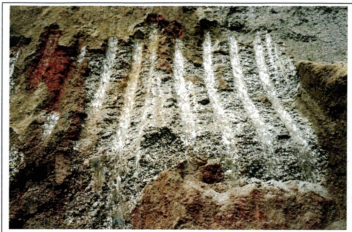
Figura 4.2.b - Vista do detalhe da jazida de material para o trecho: BRUSQUE
