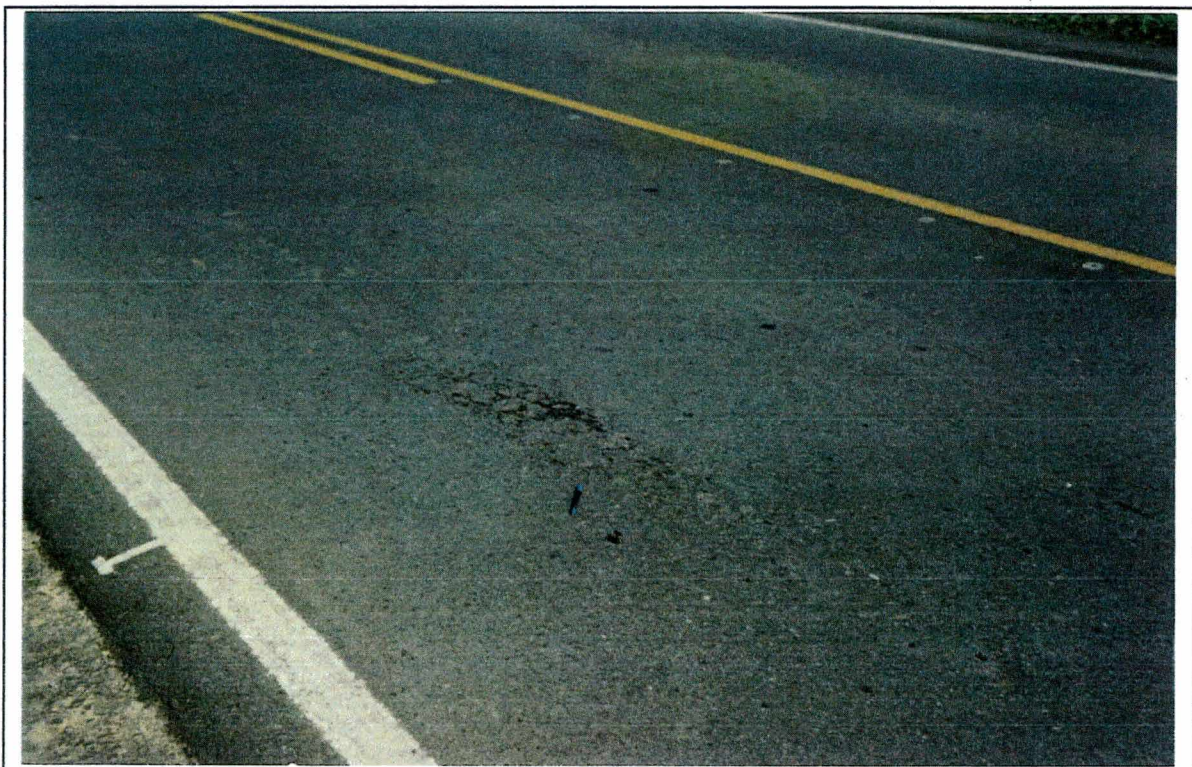
b) Pavimento reforçado com 5,0 cm de CAUQ, após 3 anos de sua execução
