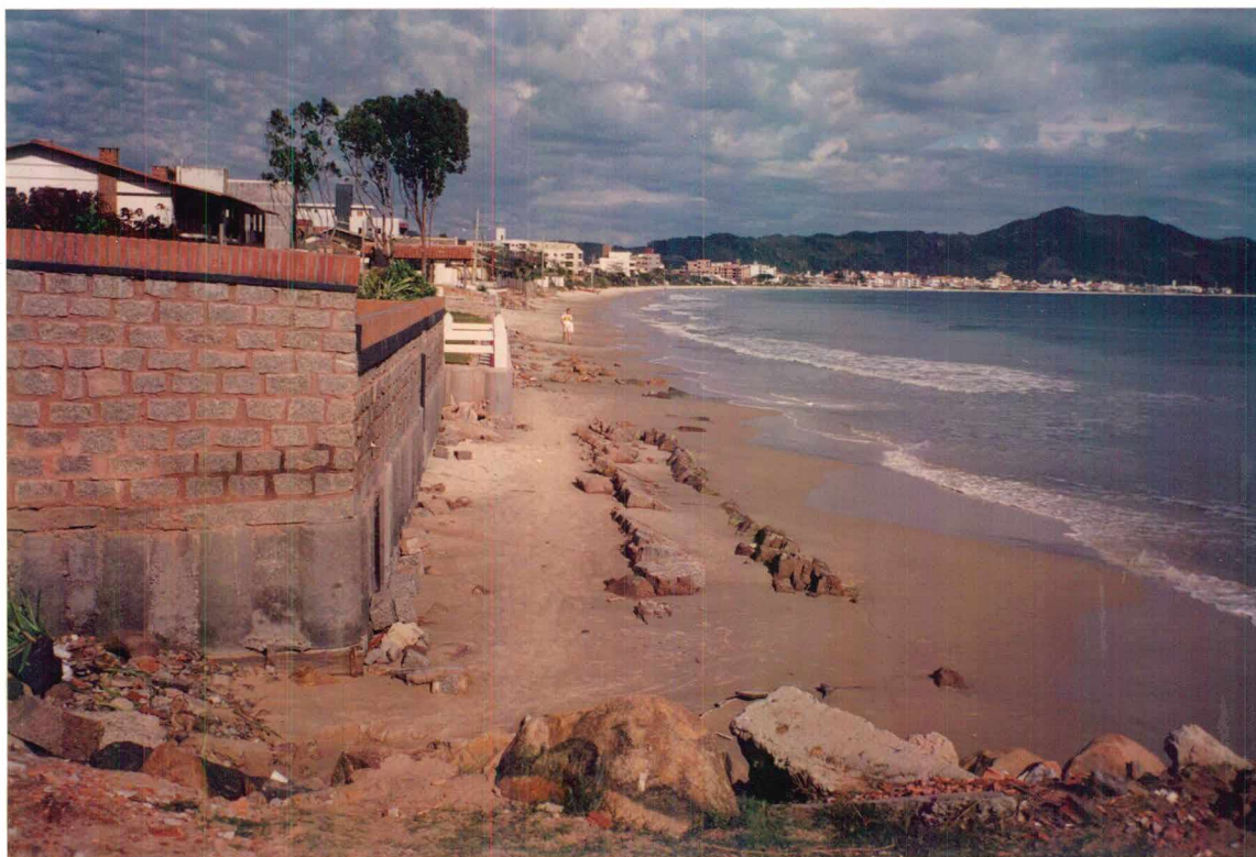
Foto 2 - Praia dos Ingleses: mostra os atuais muros de proteção contra a erosão provocada pelo mar e a posição na areia da praia onde os mesmos se encontravam. Mostra também o aterro da praia (proibido pela legislação).
