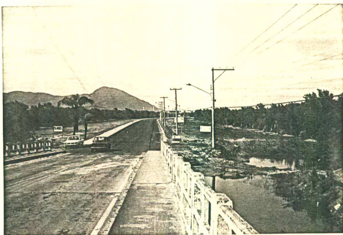
Foto 18 - Aterro sobre o manguezal para construção da rodovia SC 401, próximo a foz do rio Tavares.
