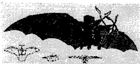
*Fig. 2- Aparelho para navegação aérea, patente requerida em 1890 por Clément Ader*
