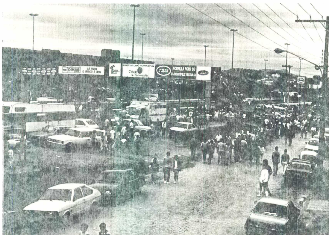
Figura 18 - Passarela sobre as pistas do circuito.
