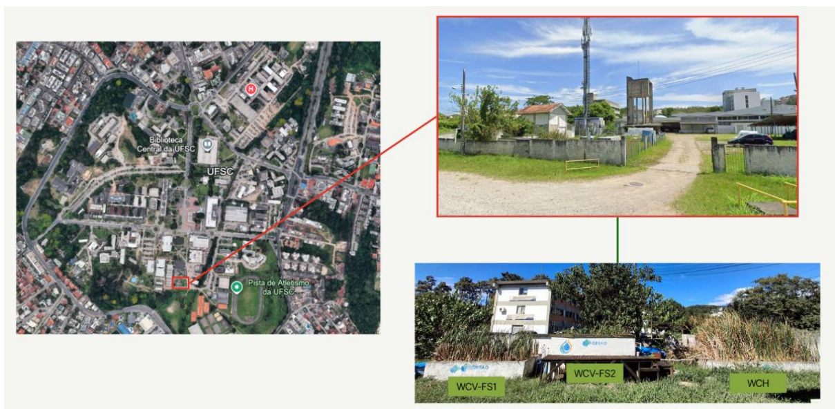
Figura 10. Localização dos wetlands construídos verticais de fundo saturado desenvolvidos e operados pelo Grupo de Estudos em Saneamento Descentralizado
