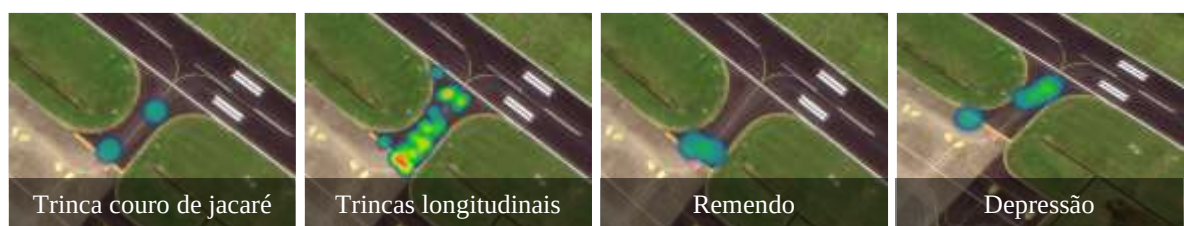
Figura 5.17 - Mapa de calor de concentração de defeitos no pavimento - Taxi B.
