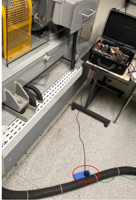
Figura 25 – Medição do campo externo ao tubo que leva os cabos de alimentação da bancada
