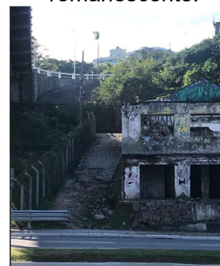
Figura 164 - Vista frontal da edificação remanescente.
