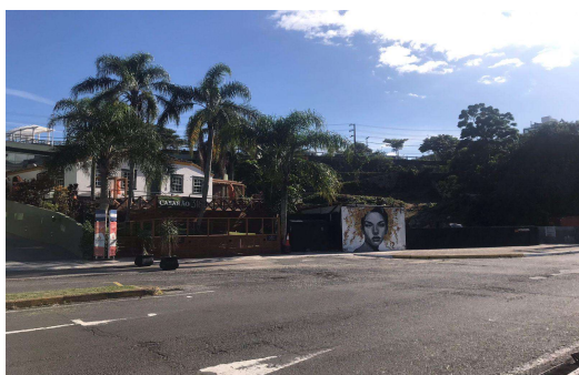
Figura 40 - Edificação situada na Rua Henrique Valgas, 318.
