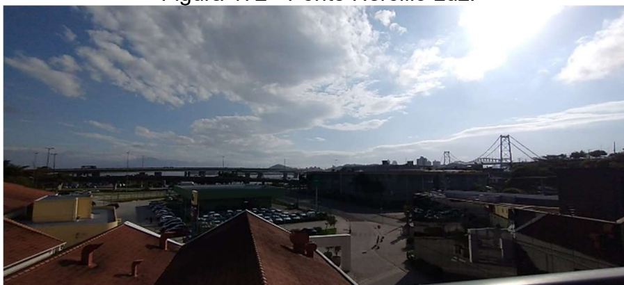
Figura 172 - Ponte Hercílio Luz.
