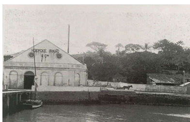
Figura 14 - Parte das instalações do complexo Rita Maria.
