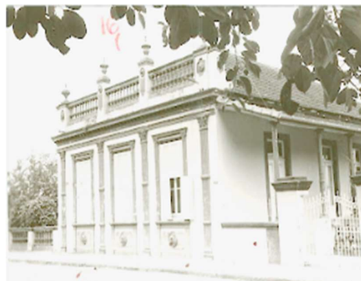
Figura 27 - Edificação eclética situada na Rua Cristóvão Nunes Pires, 16.
