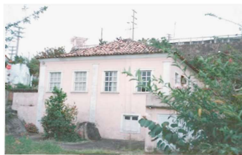
Figura 43 - Edificação situada na Rua Henrique Valgas, 38.
