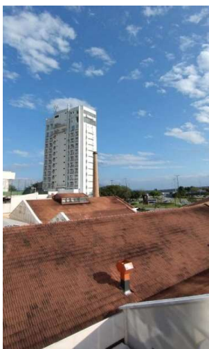
Figura 60 - Cobertura e chaminé da antiga Fábrica de Pontas.
