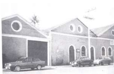
Figura 84 - Vista para Fábrica de Gelo.
