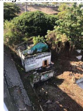
Figura 171- Ponte e remanescentes ao antigo estaleiro Arataca.
