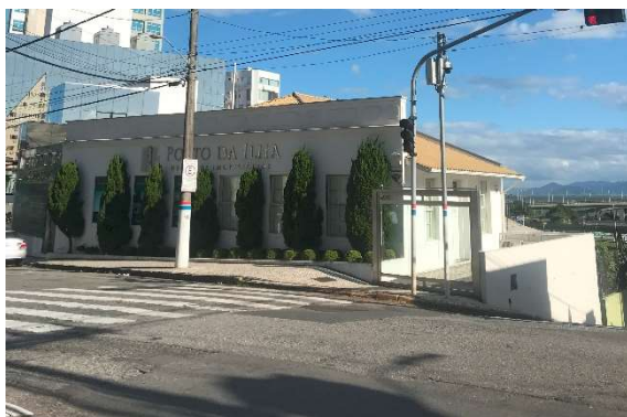
Figura 28 - Edificação eclética situada na Rua Cristóvão Nunes Pires, 02.
