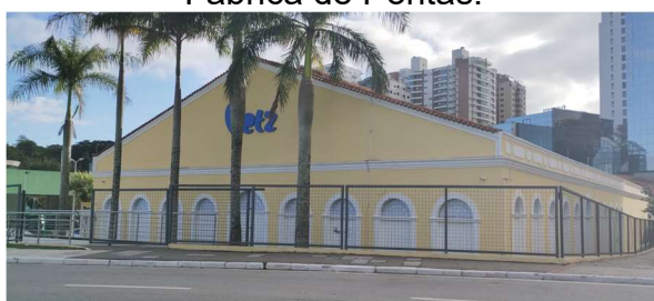
Figura 150 - Antigo depósito, em frente a Fábrica de Pontas.
