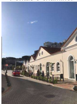
Figura 188 - Fábrica de Pontas e chaminé.
