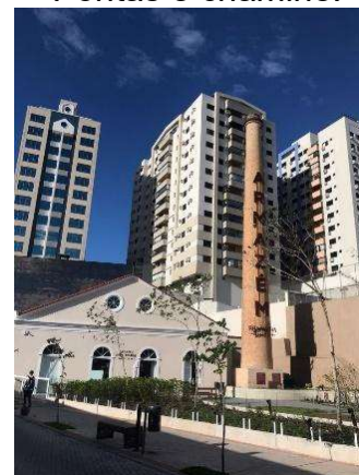
Figura 189 - Fábrica de Pontas e chaminé.
