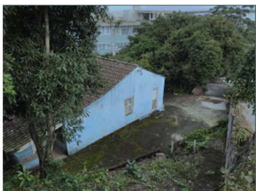
Figura 36 - Edificação na Rua Henrique Valgas – s/n.
