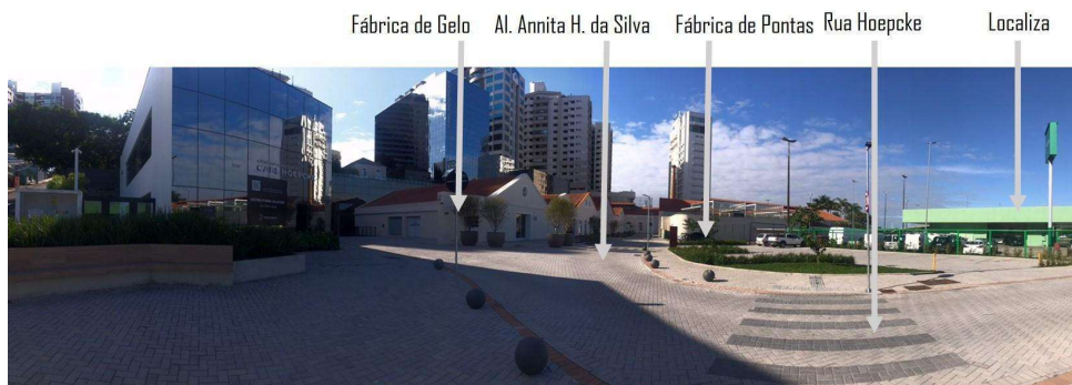
Figura 52 - Fábrica de Pontas e Gelo e chaminé de tijolos.
