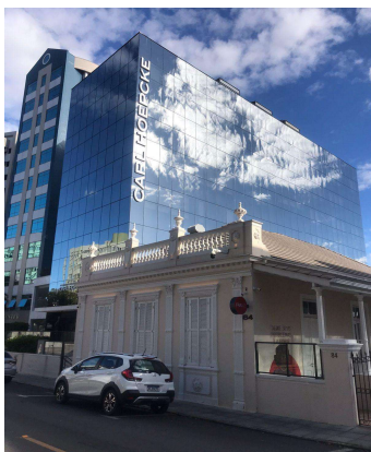
Figura 26 - Edificação eclética situada na Rua Cristóvão Nunes Pires, 16.
