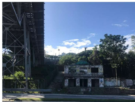
Figura 45 - Ruína da edificação remanescente.
