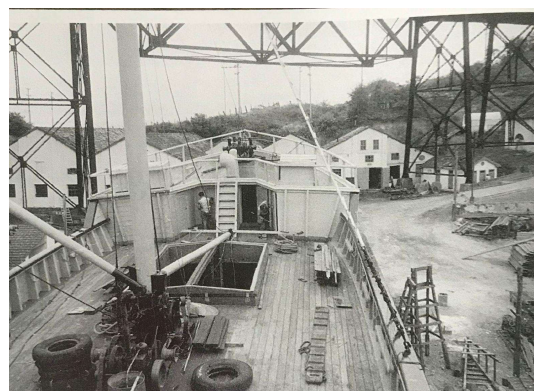
Figura 105 - Instalações do estaleiro Arataka.
