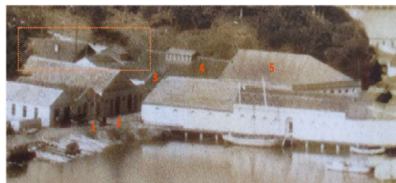
Figura 69 - Coberturas das ampliações aos fundos da fábrica.
