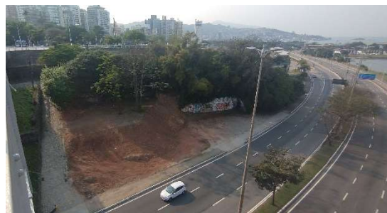
Figura 112 - Situação após demolição.
