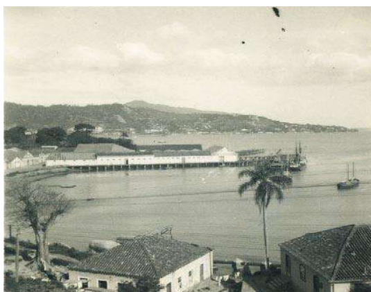
Figura 74 - Vista para Fábricas de Pontas, armazéns e trapiche.
