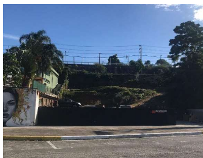
Figura 42 - Edificação situada na Rua Henrique Valgas, 38, já demolida.
