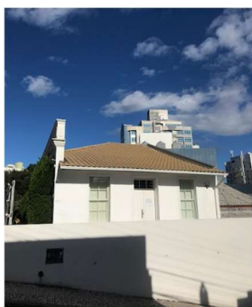
Figura 94 - Casa 02 - Rua Hoepcke, 16 (Identificação do SEPHAN, 1992).
