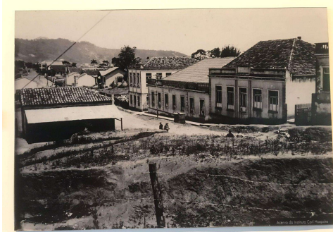
Figura 114 - Primeiras instalações da fábrica.
