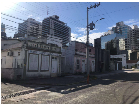
Figura 38 - Edificações ecléticas situadas na Rua Henrique Valgas.
