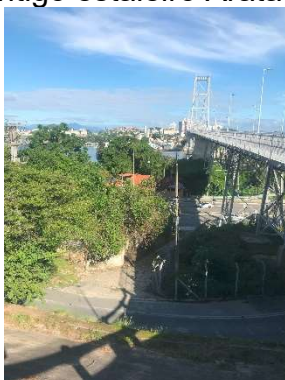
Figura 169 - Ponte e remanescentes ao antigo estaleiro Arataca.
