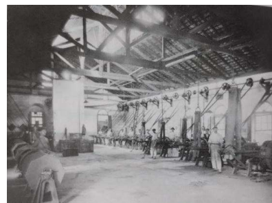
Figura 58 - Sala de máquinas.
