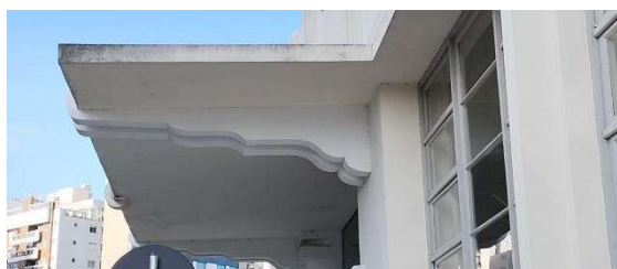
Figura 129 - Detalhe da marquise.
