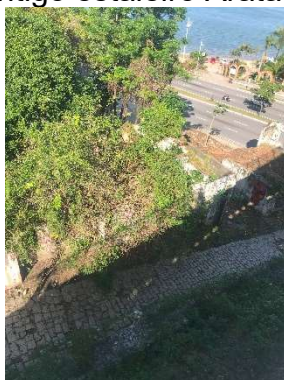
Figura 170 - Ponte e remanescentes ao antigo estaleiro Arataca.
