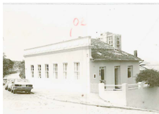
Figura 29 - Edificação eclética situada na Rua Cristóvão Nunes Pires, 02.
