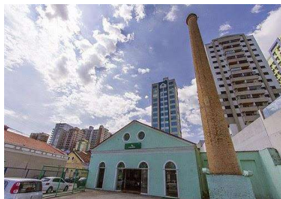
Figura 132 - Antiga Fábrica de Pontas antes do restauro.
