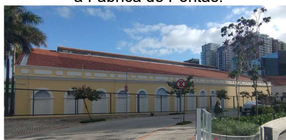
Figura 151 - Antigo depósito, em frente a Fábrica de Pontas.
