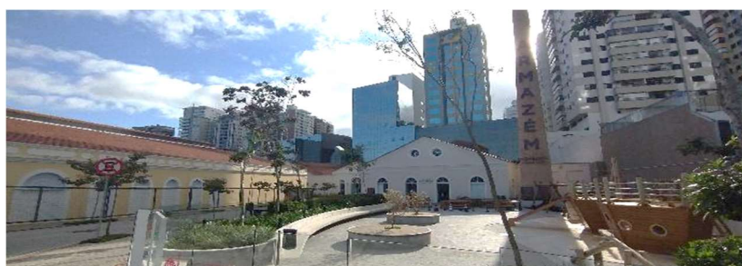
Figura 149 - Área externa, vemos galpões e chaminé.
