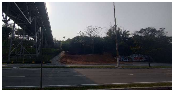
Figura 111 – Situação após demolição.
