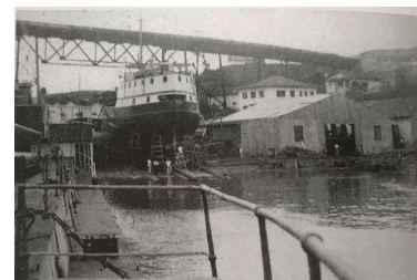
Estaleiro em funcionamento, Ponte Hercílio Luz no fundo FONTE Müller, 2007 OBSERVAÇÃO sem data identificada
