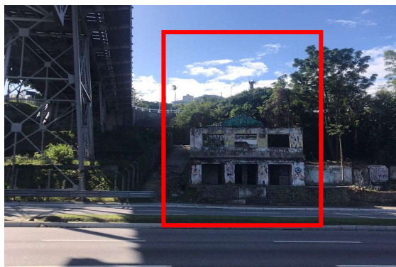
Figura 108 - Ruínas da edificação que fazia parte do estaleiro Arataca.
