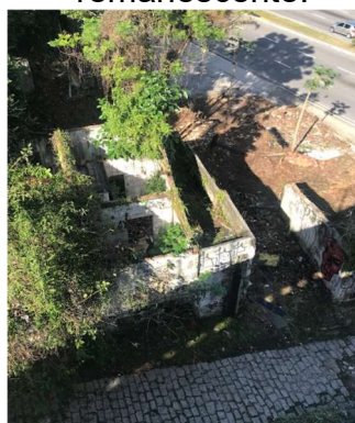
Figura 163 - Vista superior da edificação remanescente.
