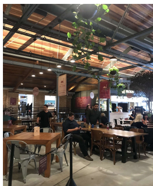
Figura 75 - Vigas e pilares em ferro da antiga fábrica.
