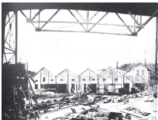
Figura 104 - Conjunto das cinco edificações do estaleiro Arataka, década de 1920.
