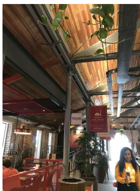
Figura 76 - Vigas e pilares em ferro.
