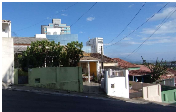
Figura 30 - Edificações que formam a vila operária.
