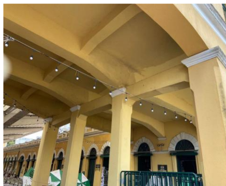
14 de Setembro de 2023, Estruturas do Mercado Público
