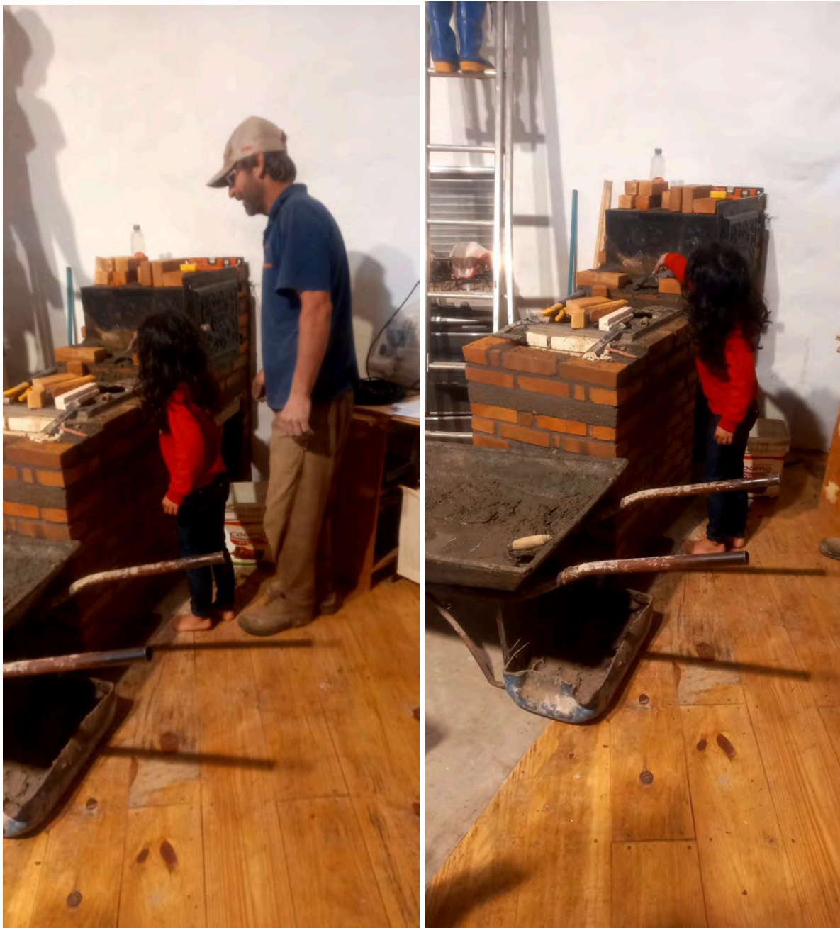
Paulo Sérgio e Tiê na construção do fogão. Fonte: Arquivo coletivo.
