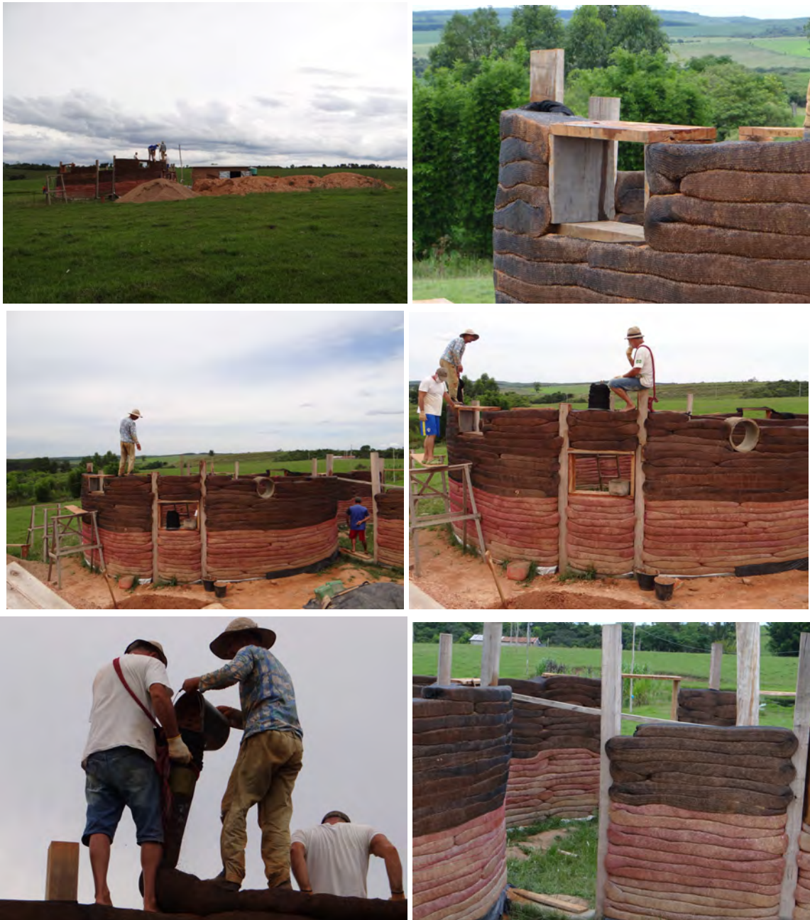
Figura 38 - Construção da Casa 8, em hiperadobe
