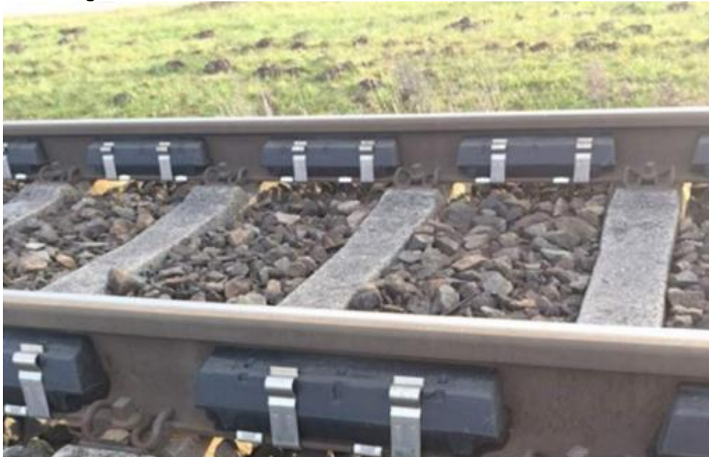
Figura 1 - Atenuador de ruído ferroviário instalado no trilho.
