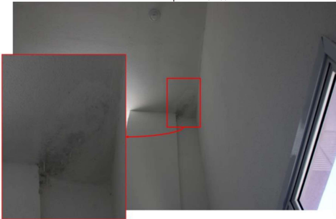
Figura 73 – Falhas de estanqueidade da impermeabilização de reservatório, evidenciada pelas estalactites (originadas pelo processo de lixiviação e carbonatação do hidróxido de cálcio) e manchamentos na pintura. - OE 30
