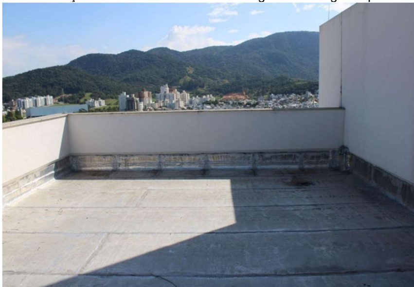
Figura 84 – Utilização de manta aluminizada em região de tráfego frequente - OE 22
