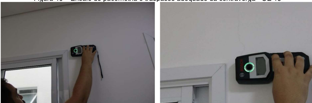
Figura 40 – Ensaio de pacometria o traspasse adequado da contraverga - OE 15
