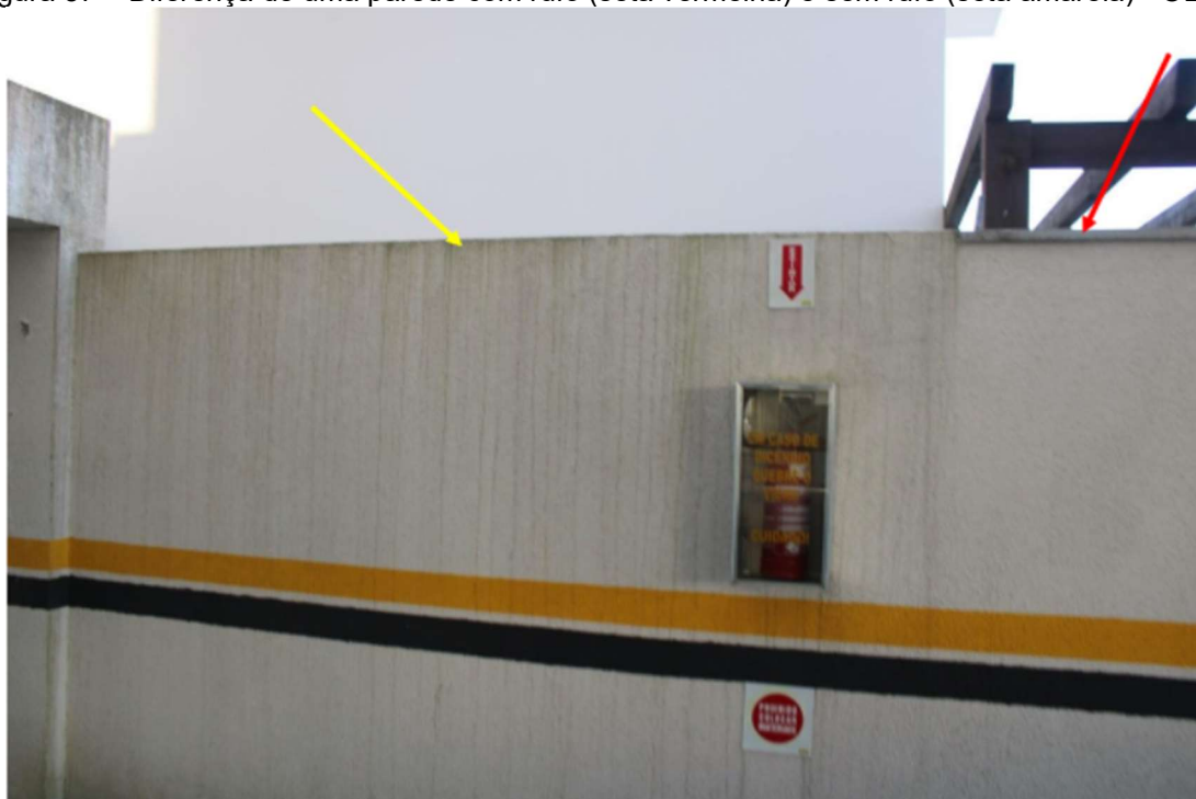
Figura 57 – Diferença de uma parede com rufo (seta vermelha) e sem rufo (seta amarela) - OE 33
