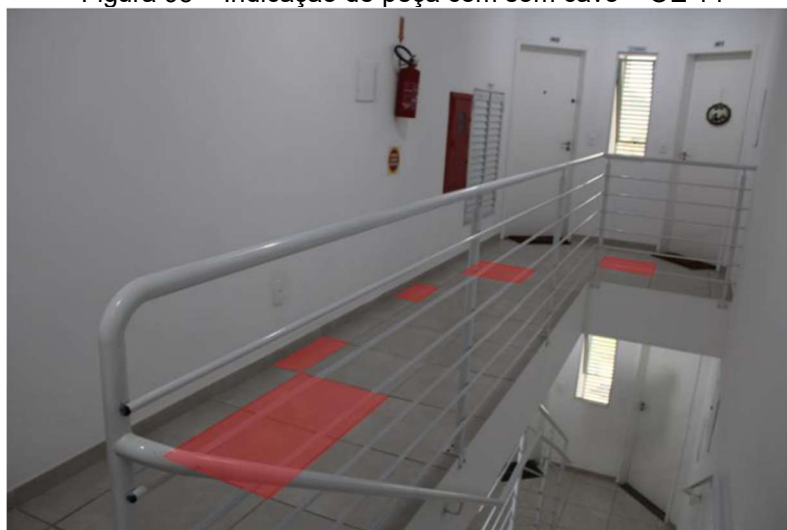
Figura 95 – Indicação de peça com som cavo – OE 14
