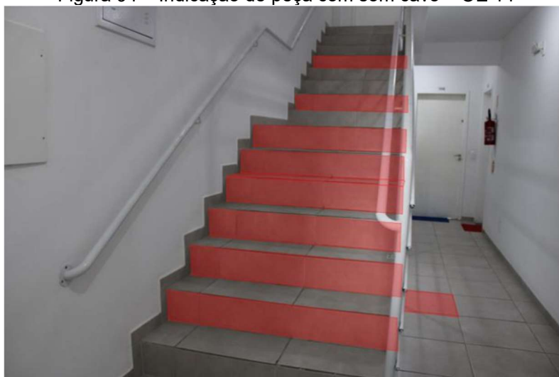
Figura 94 – Indicação de peça com som cavo – OE 14
