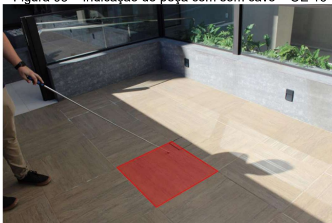
Figura 93 – Indicação de peça com som cavo – OE 16
