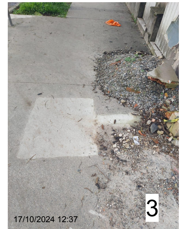
Figura 15 - Presença de restos de construção
