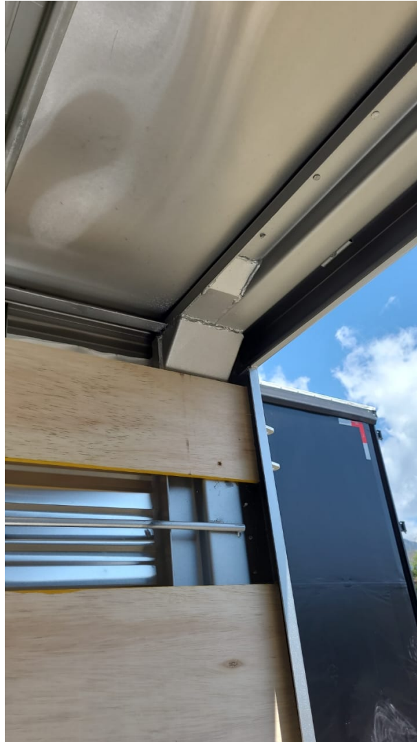
Figura 32 – Estrutura Montada com o Reforço
