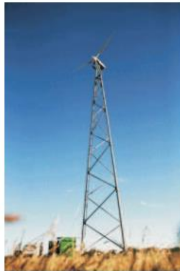
(b) Torre treliçada.
