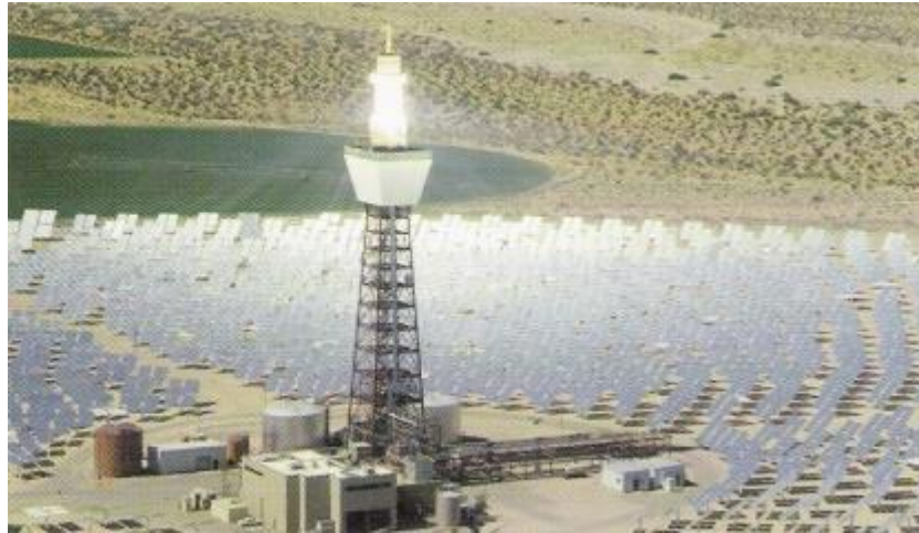
Figura 11 - Torre Central e heliostatos
