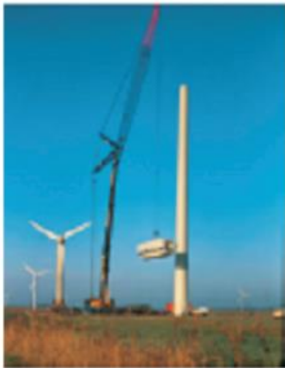
(a) Torre tubular.
