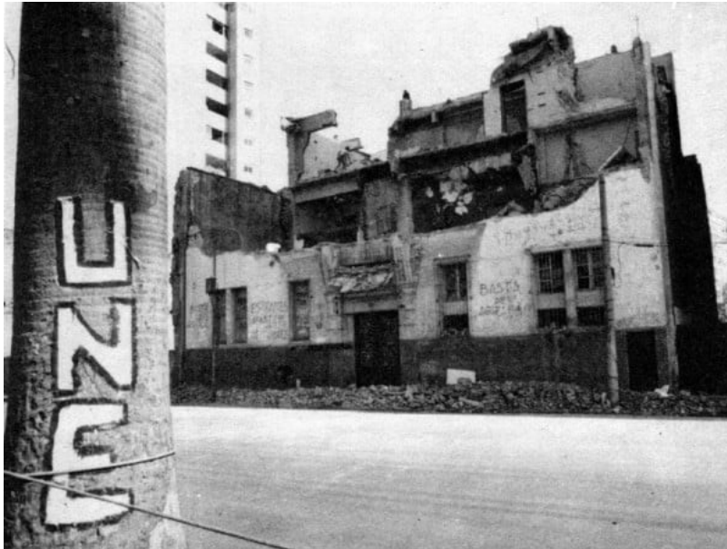
Figura 2. O prédio da UNE na praia do Flamengo em estado de demolição.
