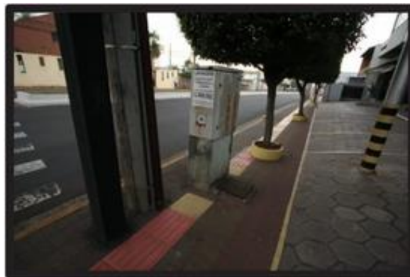
Figura 12 – Exemplo de barreira de acessibilidade urbanística em calçada
