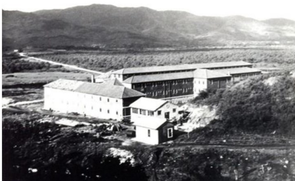
Figura 1: Imagem da Penitenciária Estadual da Pedra Grande na data de sua inauguração (Miranda, 1998).
