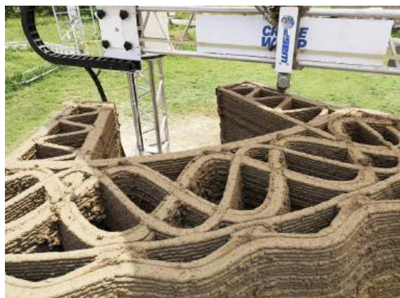
Figura 5: Construção da estrutura da casa Tecla . Fonte:WASP,2022.
