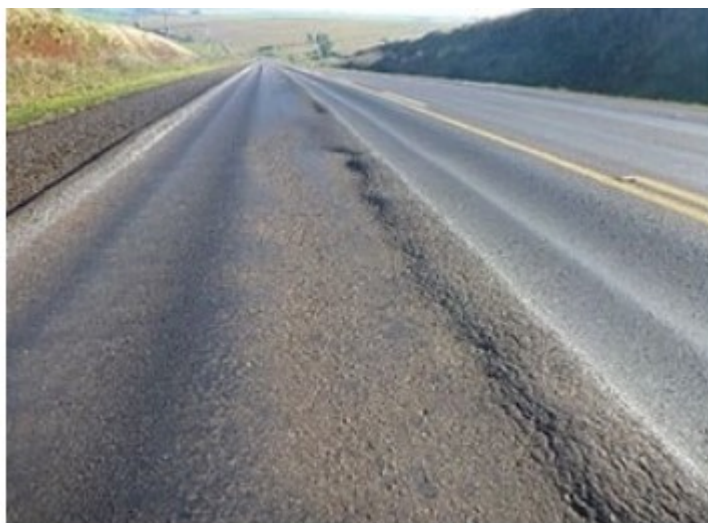
Figura 4.3 - Deformação permanente por fluência.
