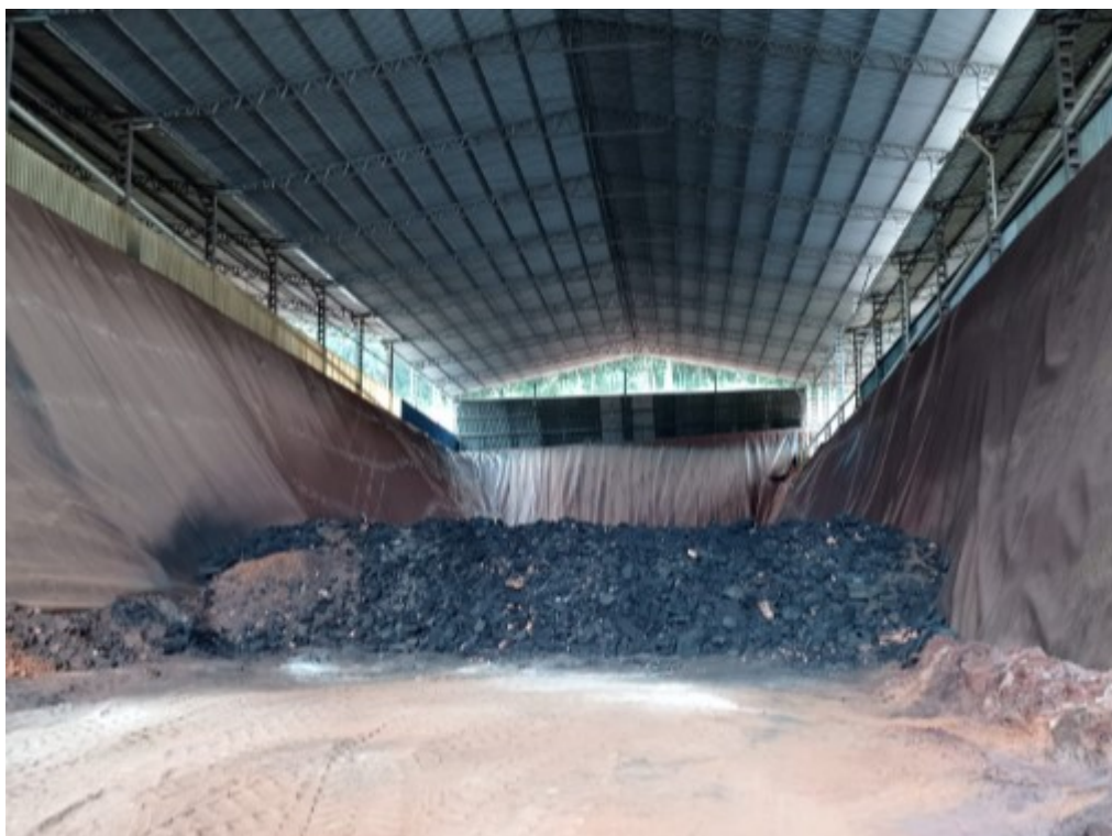
Figura 3.9 - Escória como resultada do processamento da reciclagem do chumbo.
