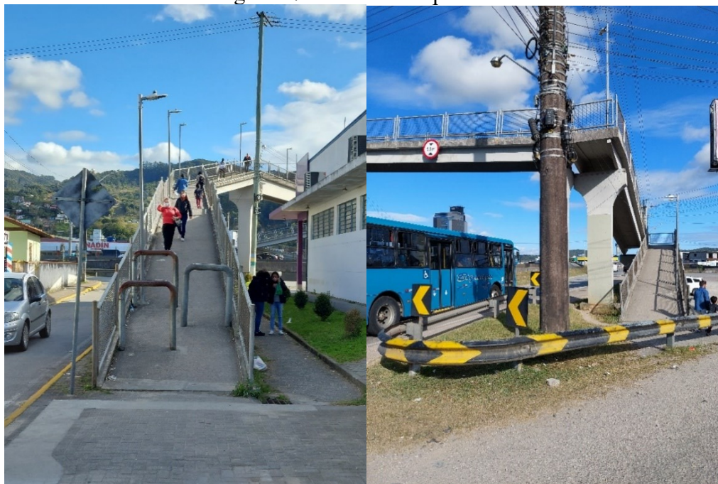
Figura 17 – Acessos da passarela
