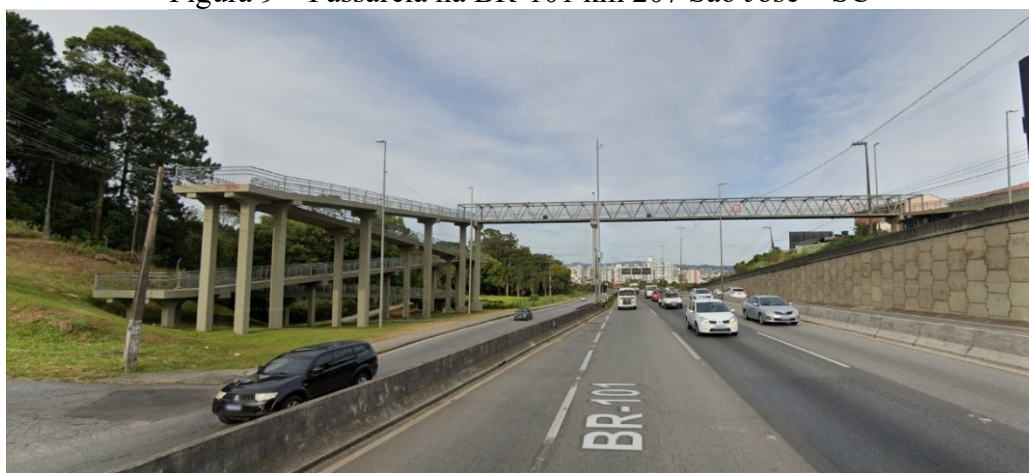
Figura 9 – Passarela na BR-101 km 207 São José – SC
