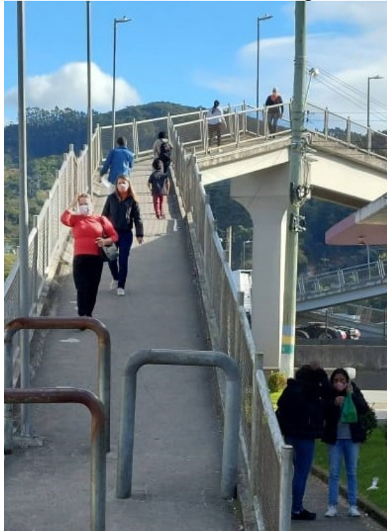
Figura 47 – Uso da passarela
