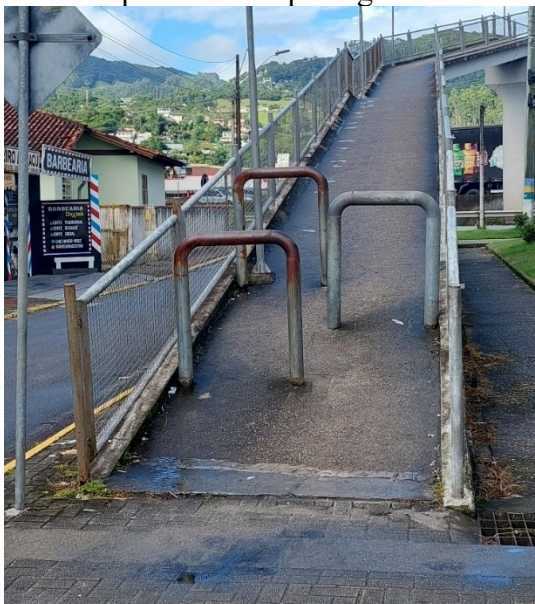
Figura 38 – Barras para evitar a passagem de veículos grandes
