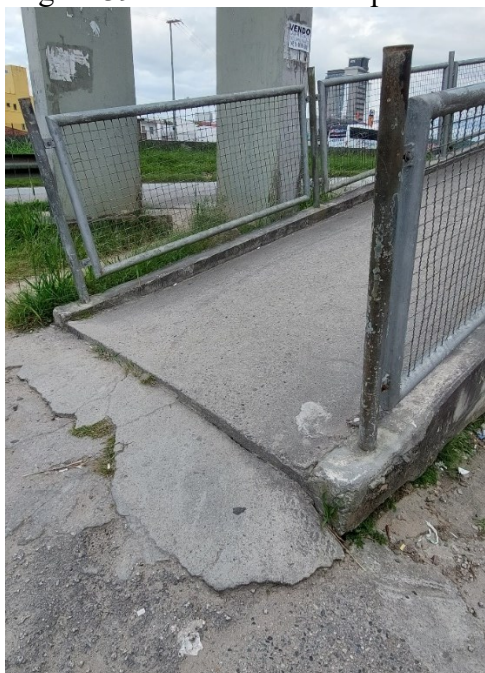
Figura 39 – Acesso Oeste à passarela
