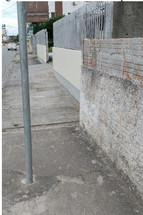
Figura 32 – Placa instalada no passeio
