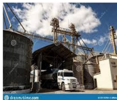
silos de grãos
