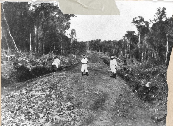
Fonte: Museu municipal de Horizontina. Estrada que liga Horizontina à Três Passos, trecho entre Horizontina e Tunas. As pessoas são funcionários da Colonizadora Dahne & Conceição, 1927.
