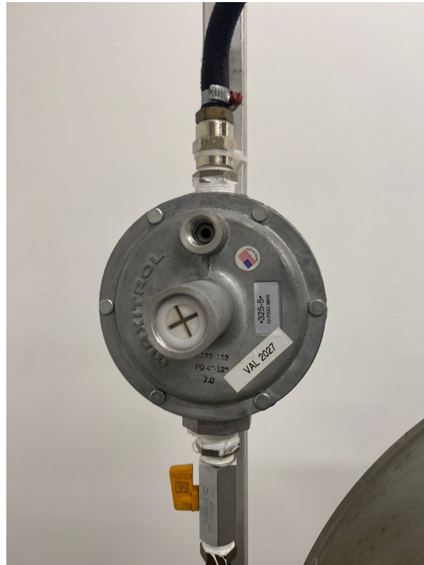
Figura 13 – Regulador de pressão.
