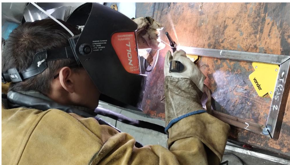
Figura 66 – Soldagem da bancada de teste
