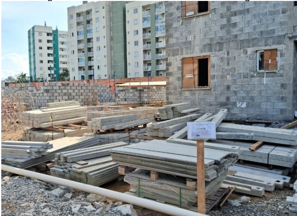
Figura 22 - Armazenamento de Ardósias e Vergas
