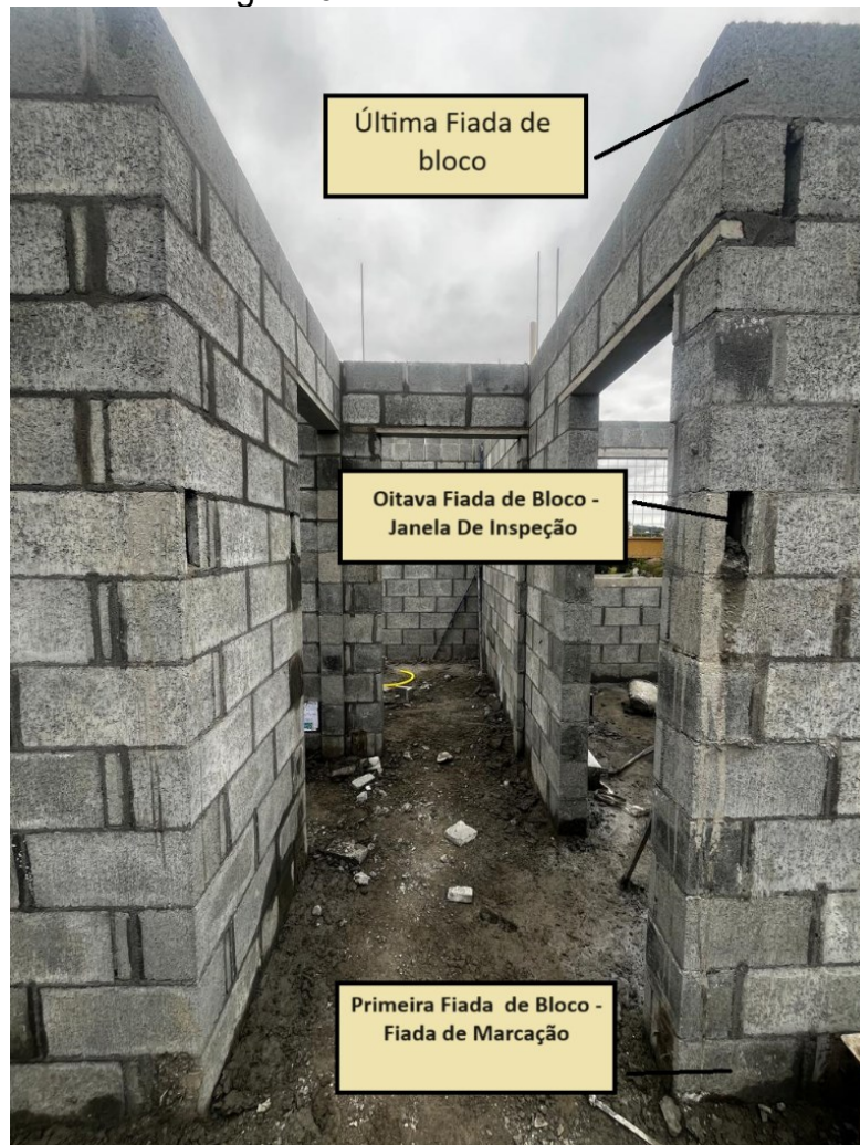
Figura 6 - Fiadas da alvenaria
