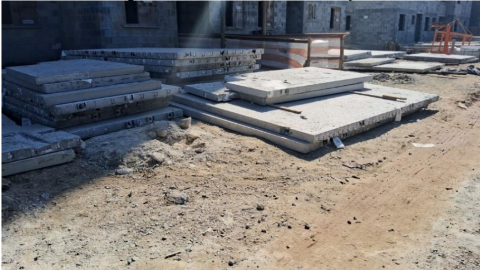
Figura 21 - Armazenamento de lajes
