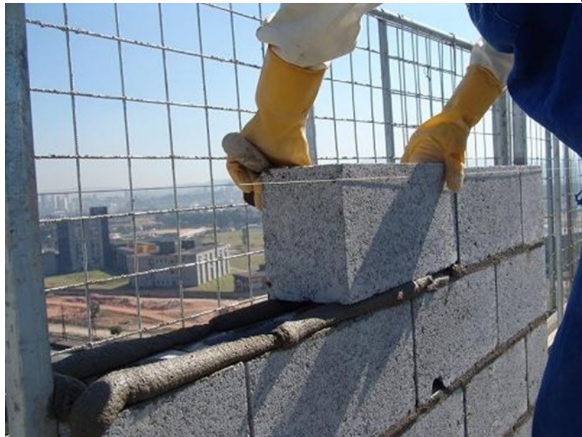
Figura 5 - Assentamento de bloco estrutural com os cordões de argamassa
