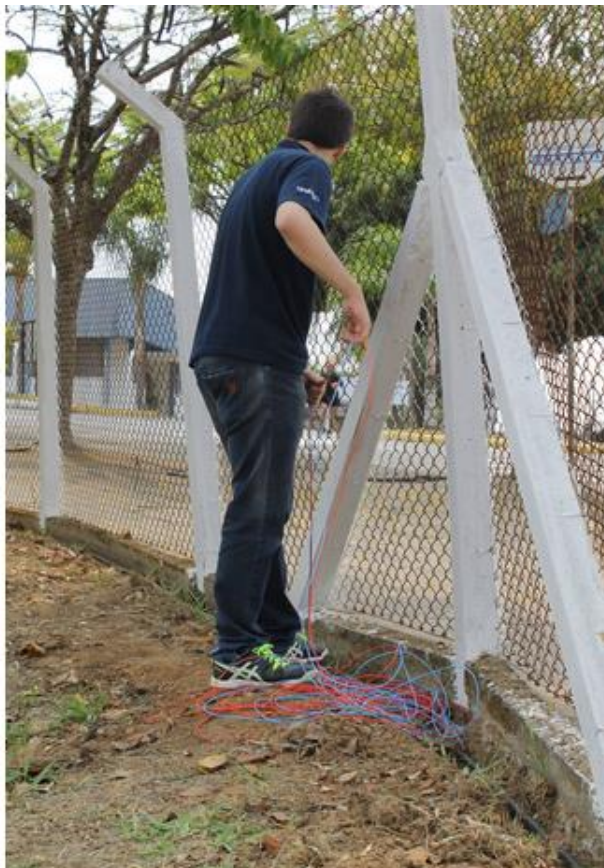
Construção exigiu longo planejamento. Imagem: Acervo/Iniciativa Ponto Iluminado
