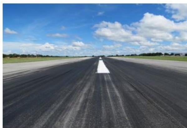
(d) Acúmulo de borracha em pavimento de pista de pouso e decolagem, detectado por meio de inspeção visual.
