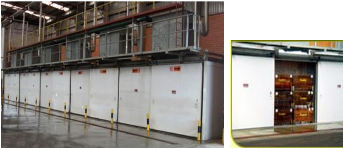
Figura 7. Sistema de pré-resfriamento de maçãs na empresa Renar Maçãs S/A – hidrocooler . Fonte: Renar Maçãs S/A, 2011.
