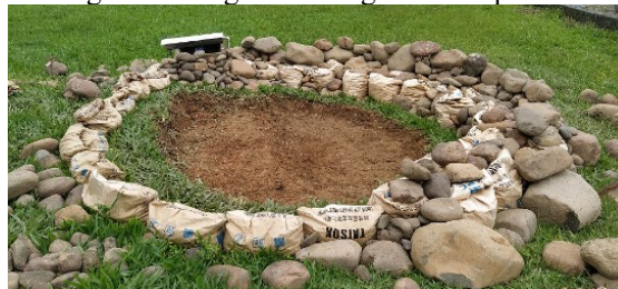
Figura 17: Lago sendo erguido com pedras.
