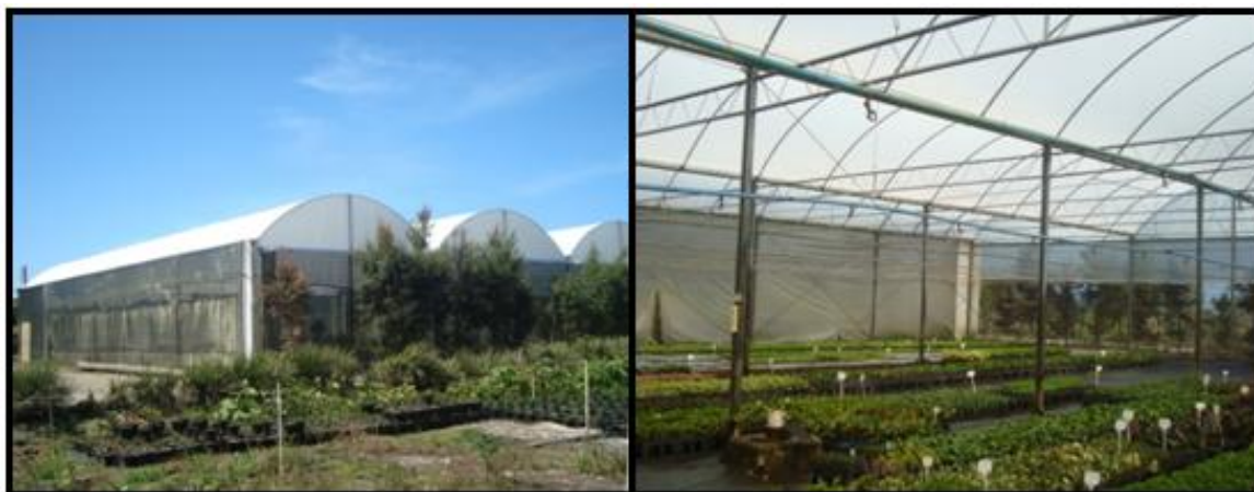
Figura 8: Estufa de estrutura metálica e coberta por plástico microbolhas para produção de mudas na Fazenda do Jardim, Biguaçu-SC 2011.
