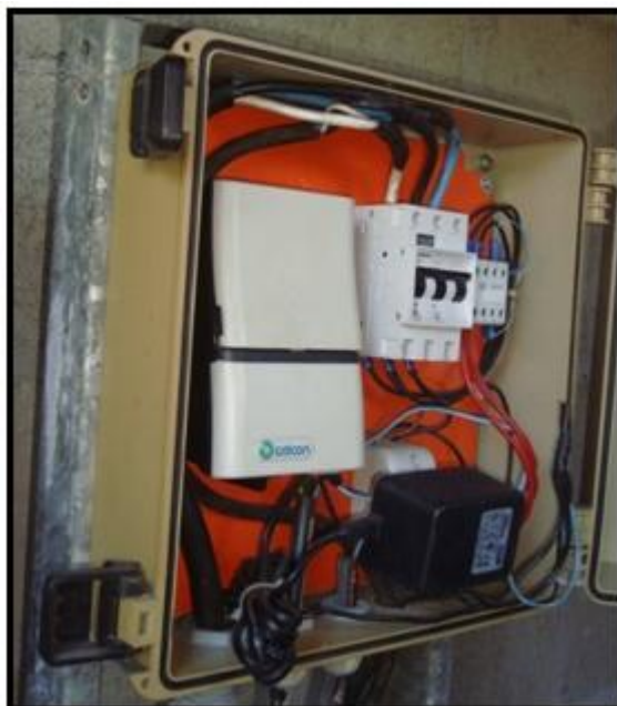
Figura 15: Controlador eletrônico utilizado na irrigação do Telado de Crescimento e no telado para aclimação das mudas da Fazenda do Jardim, Biguaçu-SC 2011.
