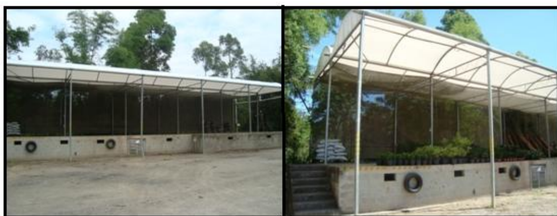
Figura 12: Doca de estrutura metálica e coberta com plástico leitoso, destinada ao carregamento das plantas na Fazenda do Jardim, Biguaçu-SC 2011.
