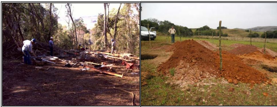
Figura 12 – Figura à esquerda da área de implantação de torre com alta movimentação de profissionais. Figura 13 - Figura à direita solo de camadas mais profundas translocado para a superfície.
