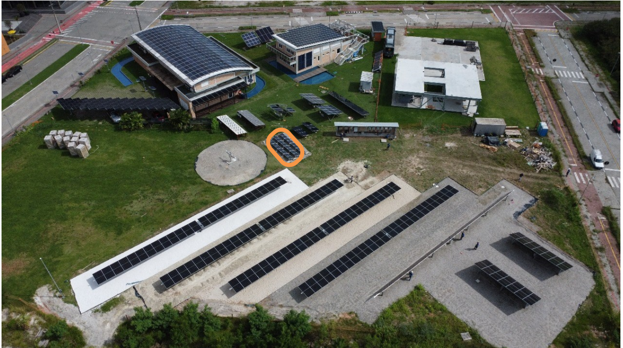
Figura 14 – Vista panorâmica traseira do Laboratório Fotovoltaica UFSC.
