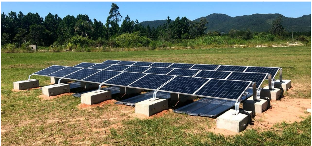
Figura 15 – Estrutura EcoGround instalada no Laboratório Fotovoltaica UFSC
