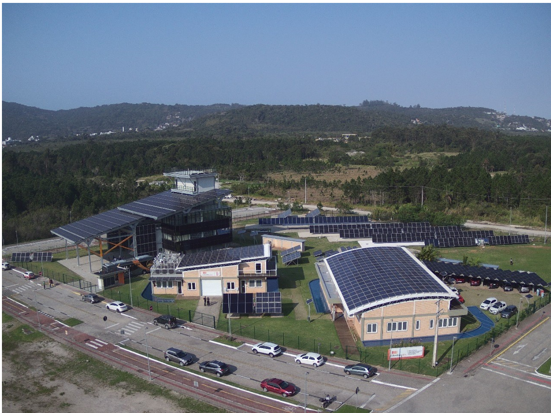
Figura 13 – Vista panorâmica do Laboratório Fotovoltaica UFSC.
