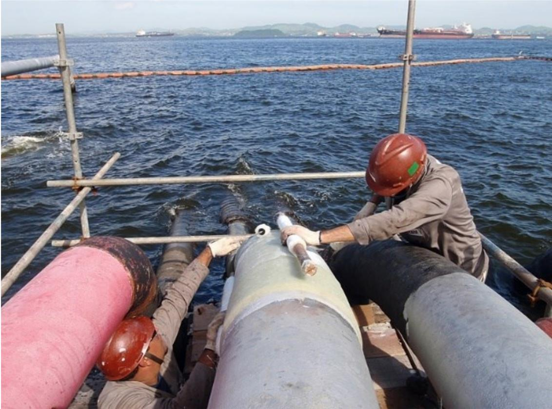
Figura 2 - Aplicação de revestimento de MC em tubulação *offshore* [8].
