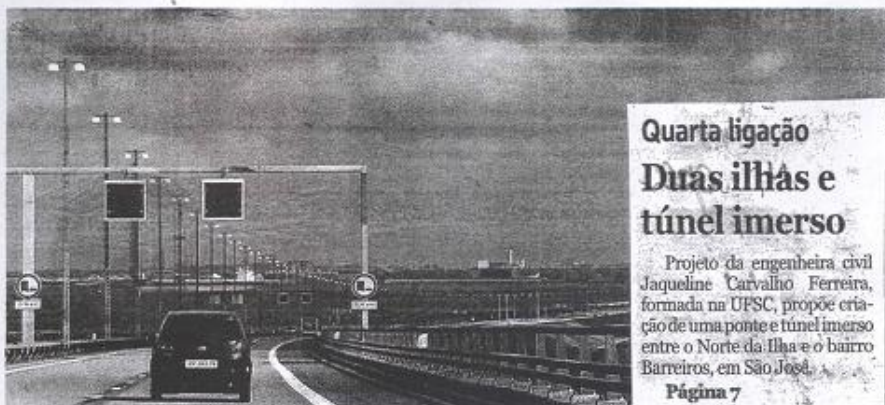
Tráfego. Duas pontes integram as ilhas artificiais e o túnel imerso
