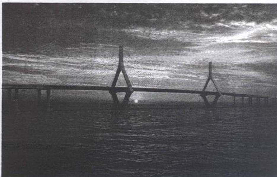
Ponte estaiada. Esse tipo de ponte, escolhida para o projeto da Engevix/Paulitec, é suspensa por cabos presos a mastros
