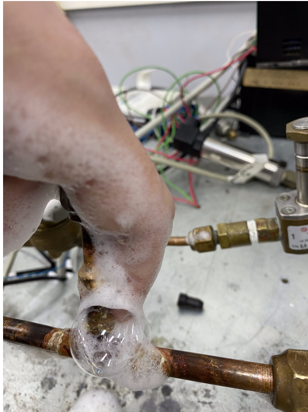
Figura 20 – Procedimento manual para detecção de vazamentos
